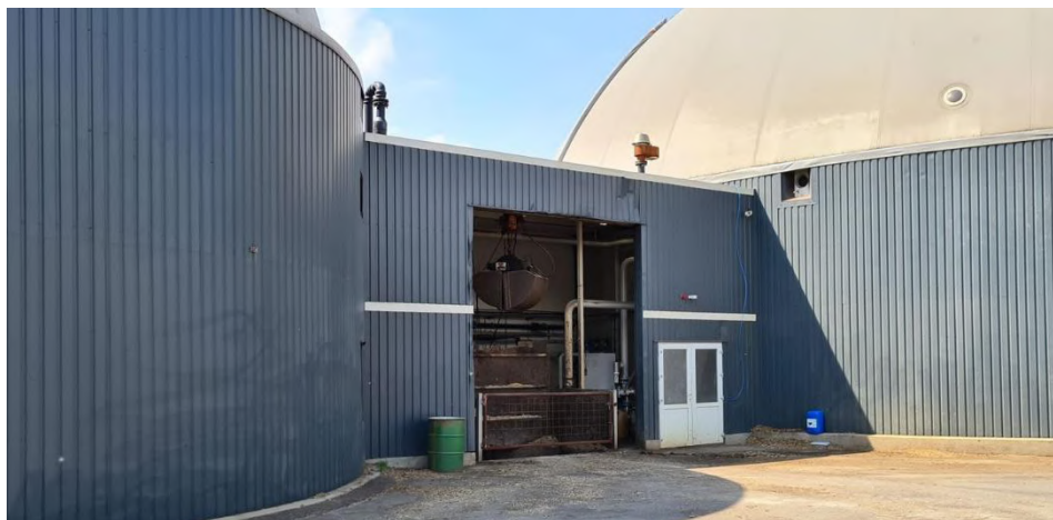
Figur 2.4: Teknikbygning imellem Mixtank til venstre og Afgassertank til højre. Bygningen er udstyret med port som giver adgang til nedgravet Indtag-tank i bygningen, hvor man indtil nu har opblandes neddelte faste biomasser i tanken, men hvor der fremover alene vil blive oplagret rågylle.
