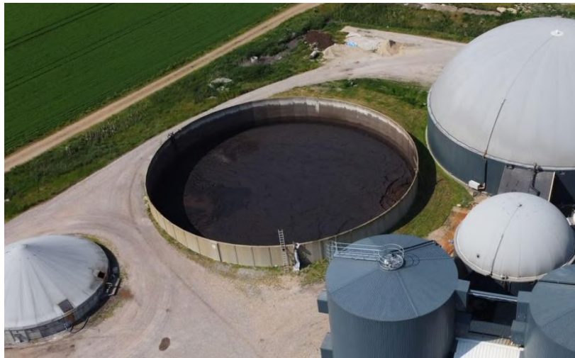
Figur 2.5: Lagertank for afgasset biomasse, som ikke er udført med fast overdækning
